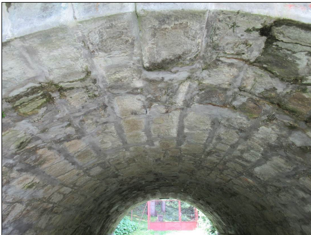
Obr. č. 5 - pohled na vrchol NK klenby zprava. V pravé části jsou průsaky patrné i ve vrchlíku za pravým čelem
