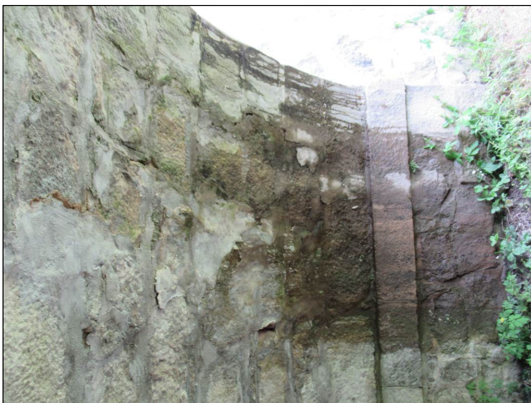
Obr. č. 6 - detailní pohled na NK klenby a průsaky nad opěrou Adamov, v pravé části.
