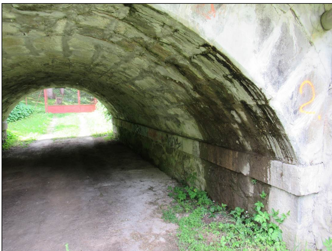
Obr. č. 4 - pohled na opěru Adamov zprava. Skrze NK klenby dochází na pravé straně k průsakům
